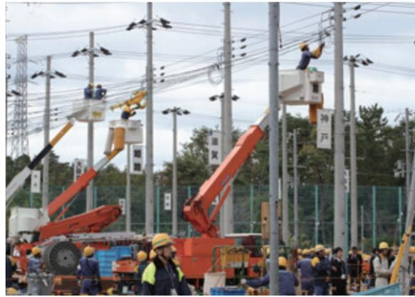
るほか、送配電カンパニーとしても、さまざまな防災訓練を行っている。例えば配電部門では、研修センターにある模擬配電設備を使った事故復旧訓練を行っているし、系統運用部門でもシミュレーター装置を用いた個人訓練やチーム訓練を日常的に実施。さらに年1回、夏場の需要ピークを迎える前には、中央給電指令所や基幹系統給電所、各地の給電制御所、送電保守担当課など関係部門が一体となった合同訓練も行い、事故復旧の手順や部門間の連携を確認している。
