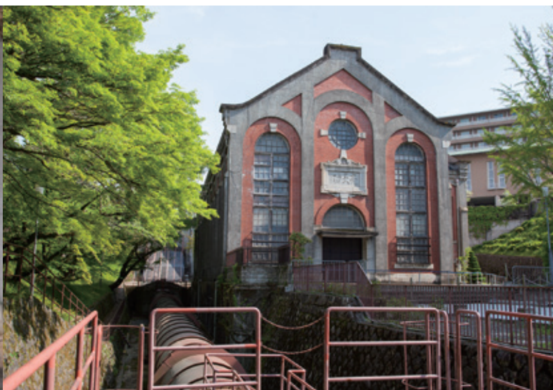
レンガ造りの第2期発電所
