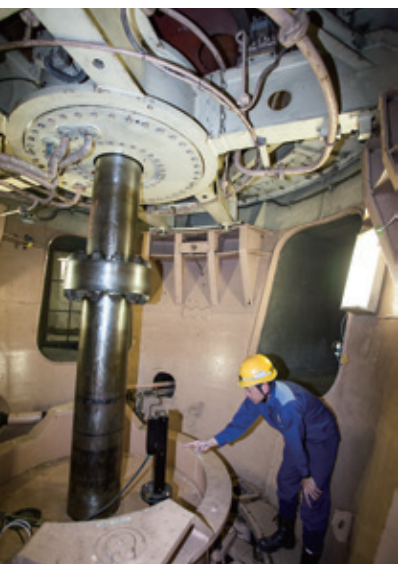
巡視点検をする中江
