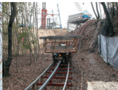
資機材は現場までモノレールで運び上げる
