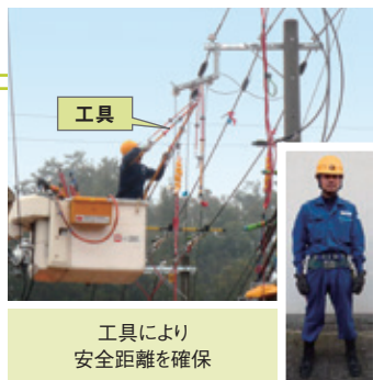
充電線路に間接的に触れる作業
