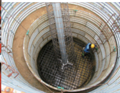
基礎（掘削・据付）工事
