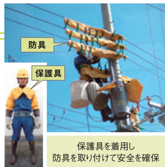
充電線路に直接触れる作業
