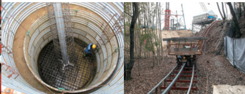
基礎（掘削・据付）工事
