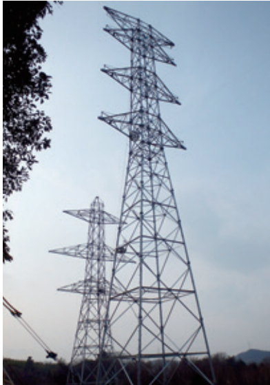
組立が完了した鉄塔 (奥は解体前の既設鉄塔)
