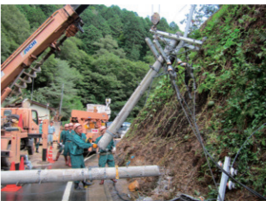
協力会社と一体となって進める災害復旧作業
