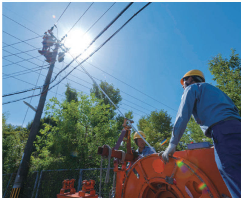
チームプレーで進める電線張り替え工事
