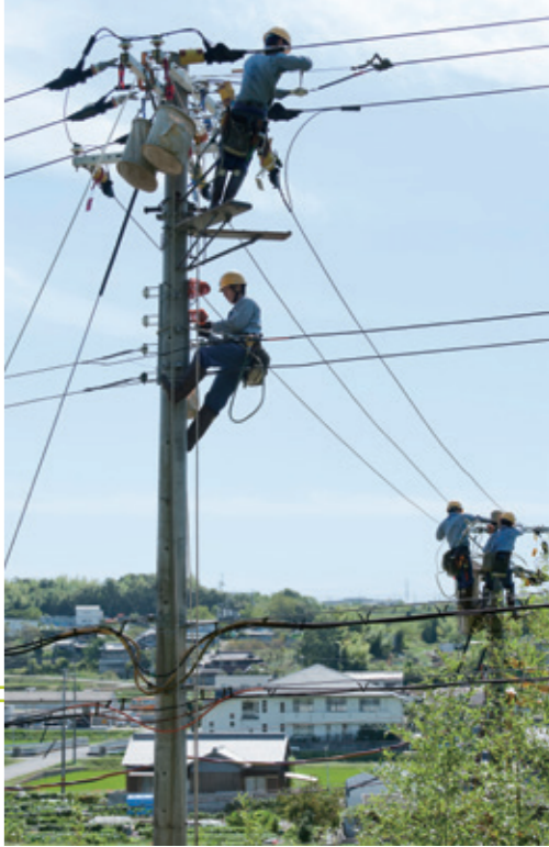
地上約12mの電柱の上で作業を行う現場作業員
