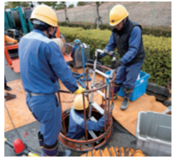
大規模ビルへの配電、高圧ケーブルの地中埋設工事
