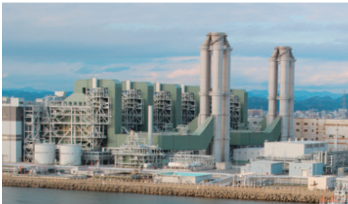
設備更新後の姫路第二発電所
