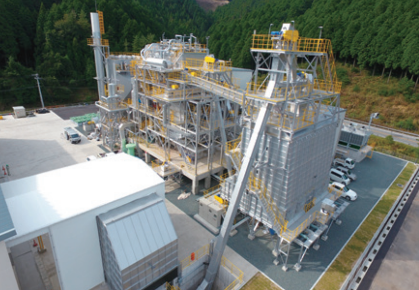
朝来バイオマス発電所
