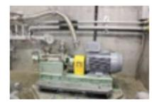
▲蒸気発生器による炉心冷却のための中圧ポンプ
