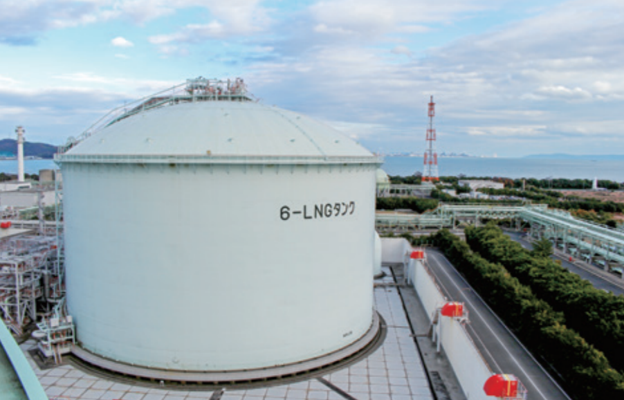
姫路LNG基地のLNGタンク
