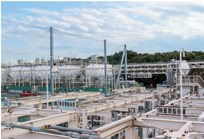
熱量調整設備
