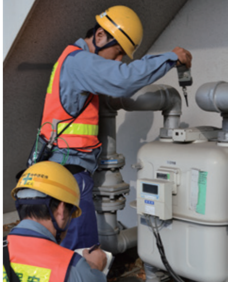
関西電力によるガス保安
