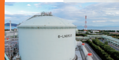
姫路LNG基地のLNGタンク
