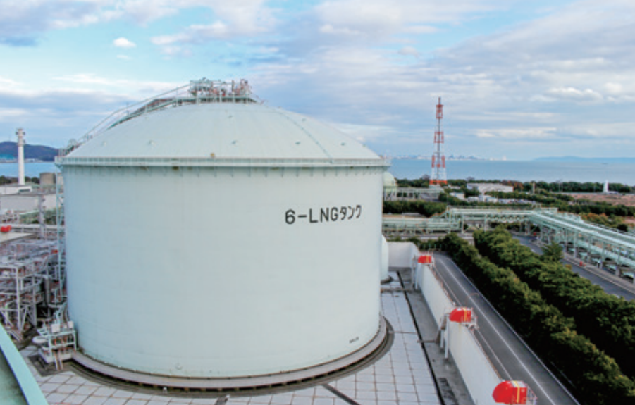
姫路LNG基地のLNGタンク
