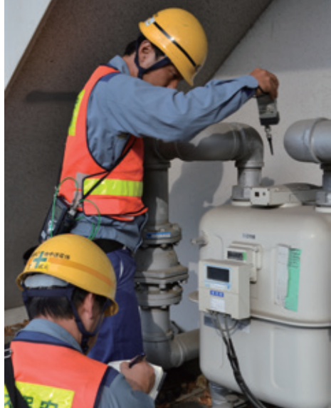
関西電力によるガス保安
