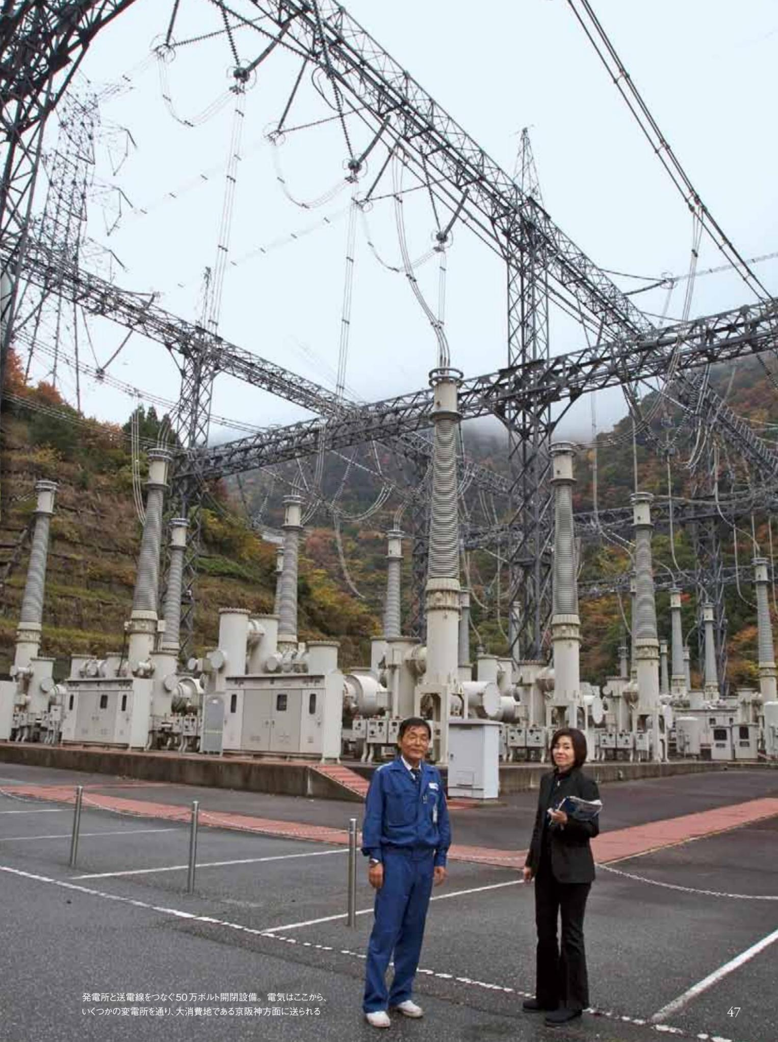
発電所と送電線をつなぐ50万ボルト開閉設備。電気はここから、いくつかの変電所を通り、大消費地である京阪神方面に送られる
