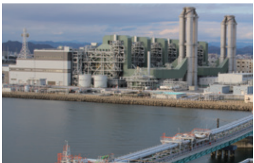
LNG受け入れ先の一つである姫路第二発電所
