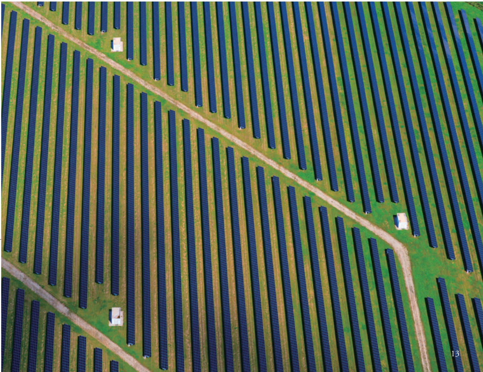
ドイツの太陽光発電プラント。ドイツは2050年に電力の8割を再生可能エネルギーで賄おうとしている ©Westend61/gettyimages
