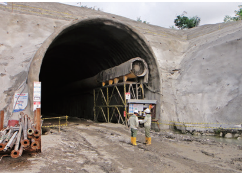
ラジャマンダラ水力の導水路トンネル
