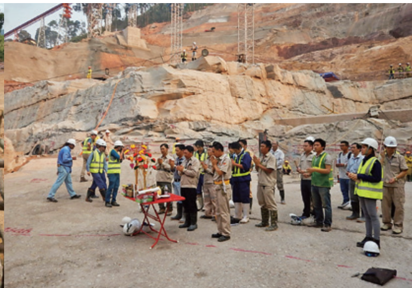
ナムニアップダムのコンクリート打設安全祈願
