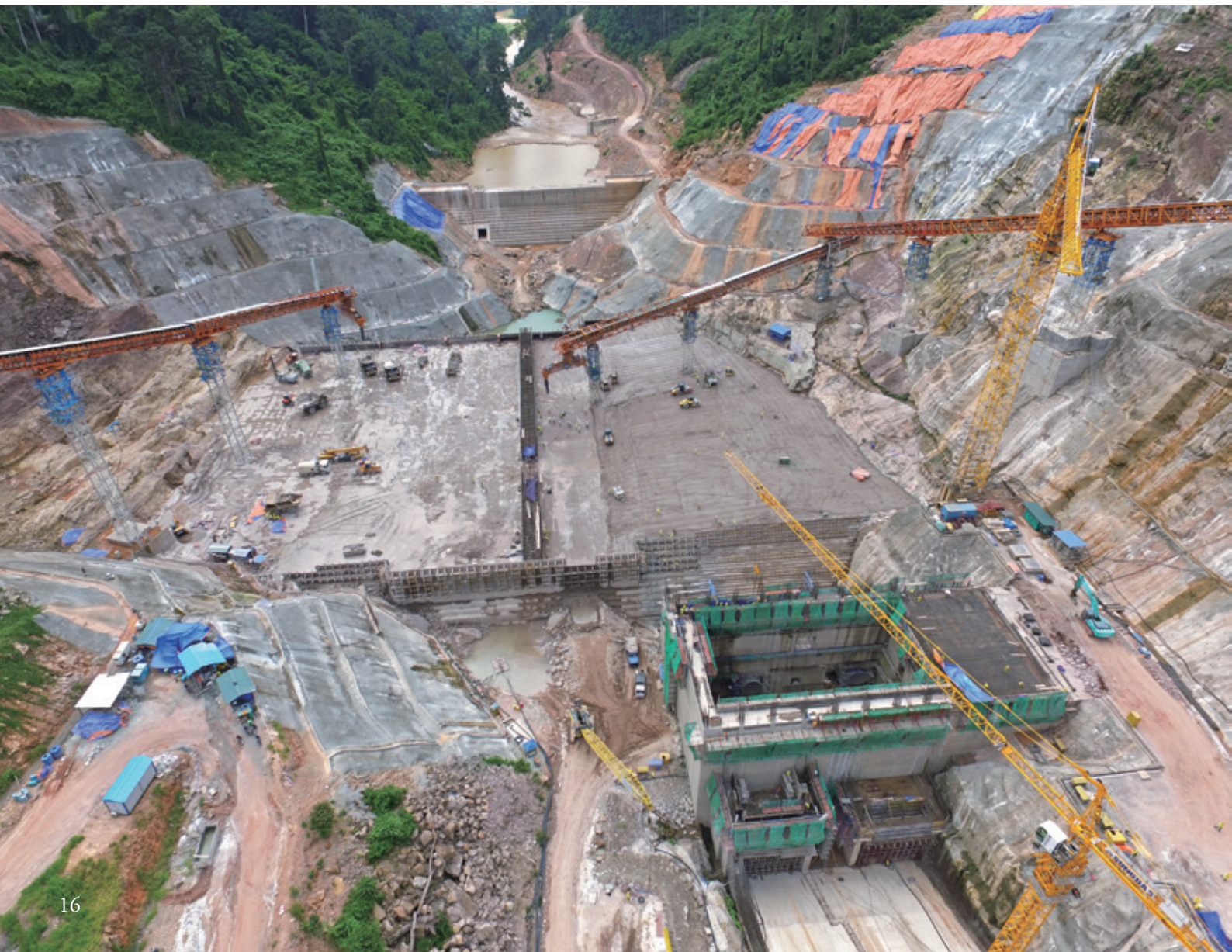
関西電力がラオスで進めているナムニアップ水力プロジェクト
