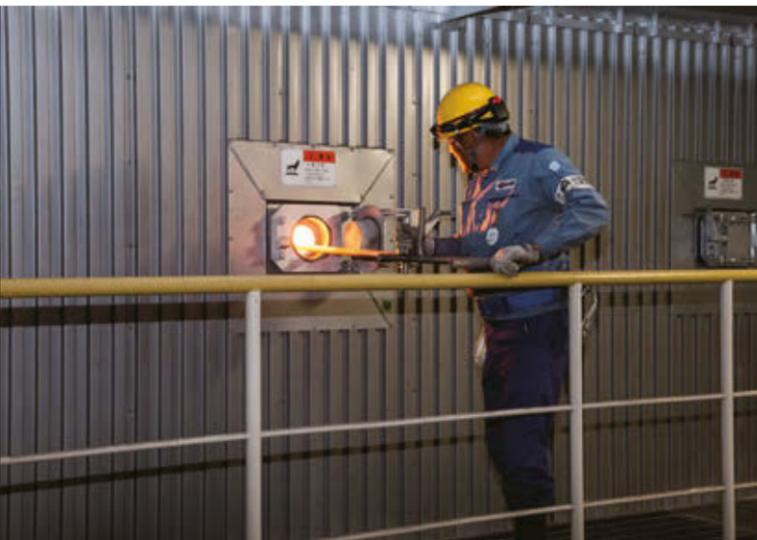
ボイラの周囲を覆うバーナ蒸発管パネル。運転中は灰の付着状況確認も行う、とボイラ主任の真砂勝
