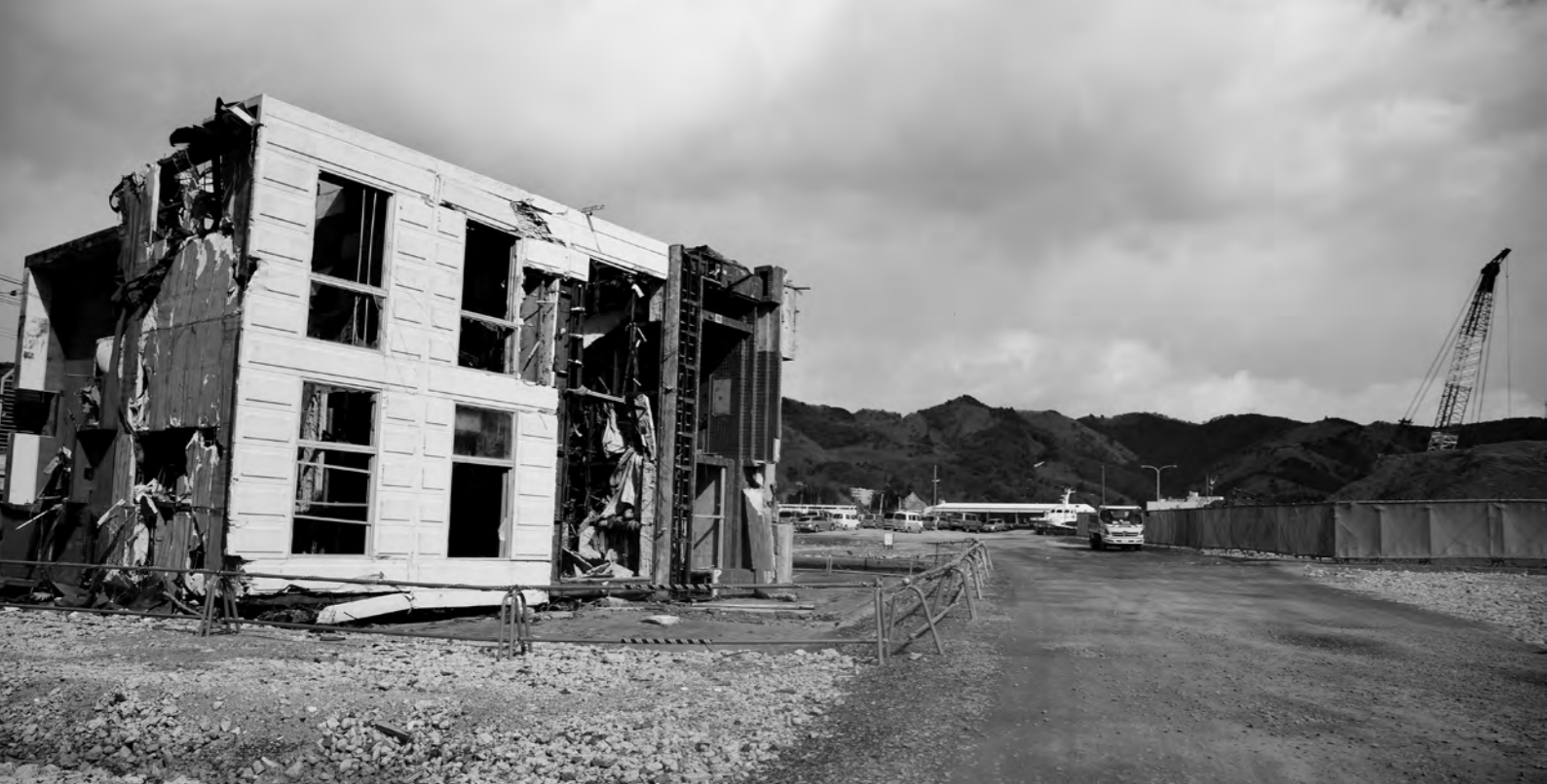
ハザードが顕在化した東日本大震災。津波で倒壊・横倒しになった宮城県女川町の江島共済会館(2013年2月撮影)。 2015年1月に撤去が完了、跡地は商業エリアとして整備されるという
