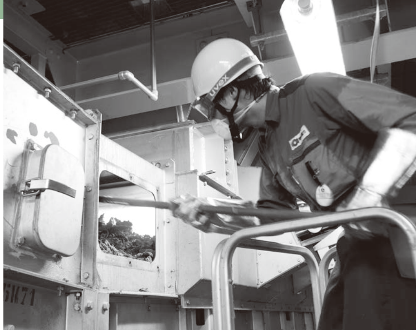
舞鶴発電所の点検作業
