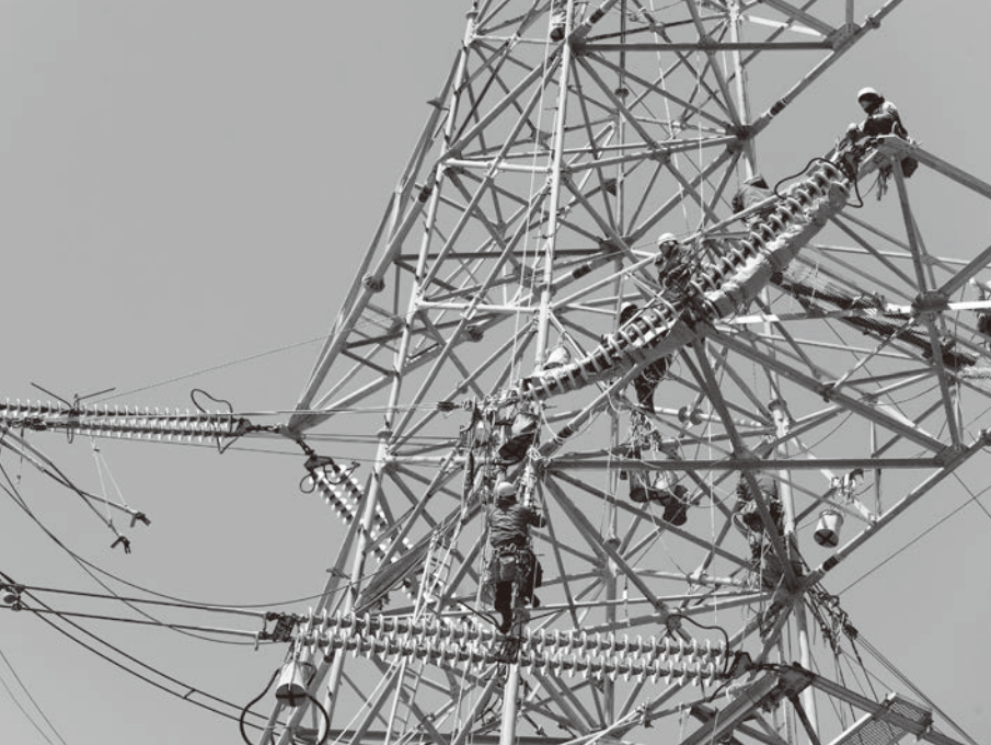
鉄塔取替工事
