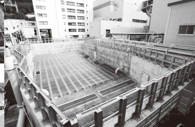
▲放水路ピットの壁を海拔約10mから15mに嵩上げ
