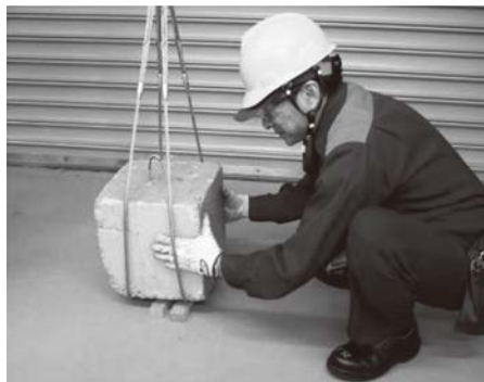
地切り時の荷振れと重量物の荷振れ、ワイヤーロープによる手・指挟まれの危険性を体感
