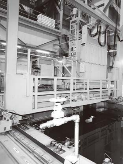
▲燃料取替クレーン
