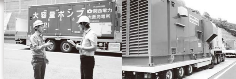
▲原子炉冷却手段も多重化・多様化。高台に配備された空冷式非常用発電装置「大容量ポンプ」も高台に
