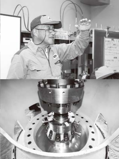
◀1次冷却材ポンプモータ
