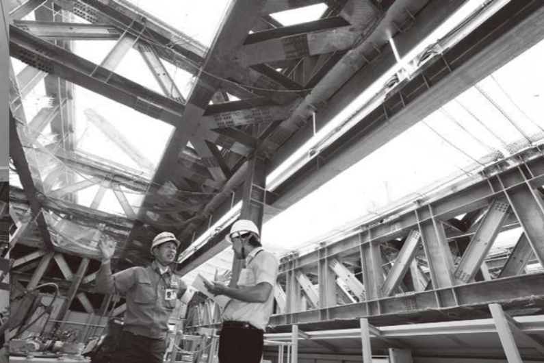
▼上面が鋼線ネットで覆われた竜巻飛来物対策設備
