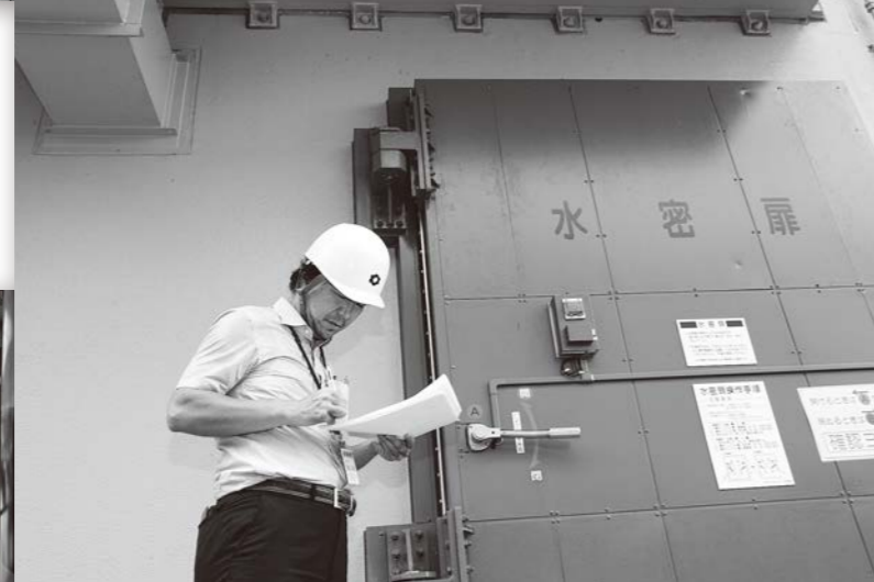
▲浸水を防ぐ水密扉。厚さ10cm以上の強固な扉が構内に40カ所以上
