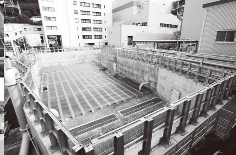
▲放水路ピットの壁を海拔約10mから15mに嵩上げ
