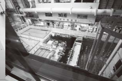
▲シースルー見学施設から燃料プールを見る。放射線防護のため、窓は鉛ガラスだ
