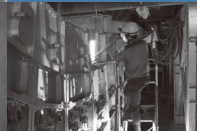
◀ボイラ内部を直接覗き込んで確認。灰を掻き出すことも
