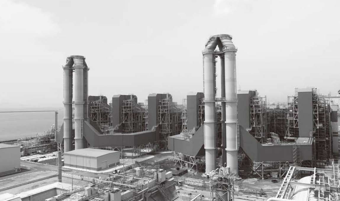
姫路第二発電所更新工事
