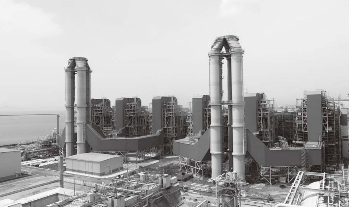
姫路第二発電所更新工事
