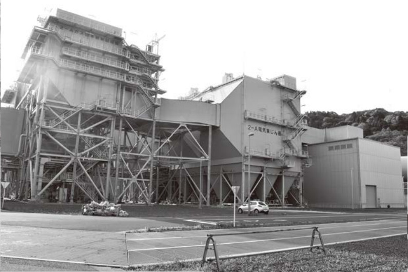
◀電気集塵機など 環境対策設備が並ぶ
