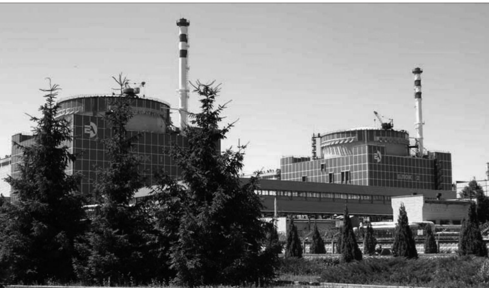
新たに2基の建設が進むフメリニツキ原子力発電所 ©Energatom
