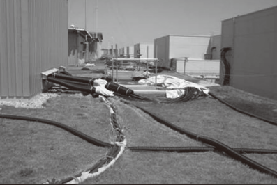
▼震災直後に所員たちがほぼ1日で敷設した仮設ケーブル
