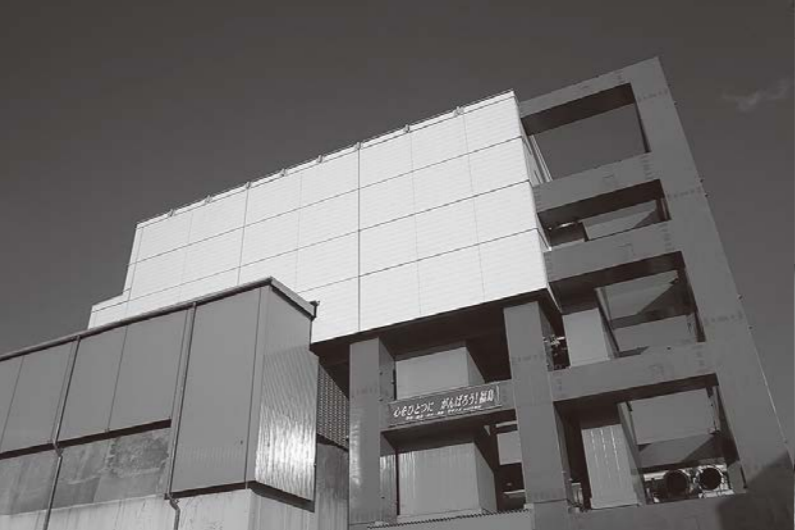
◀燃料取り出し用カバーが設置された 福島第一原子力発電所4号機
