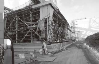
▼海側の補助ボイラー建屋
