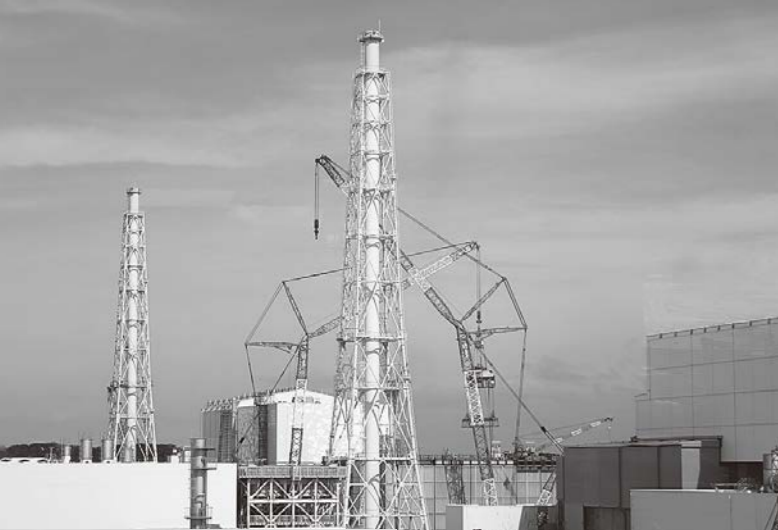
◀高台から望む 福島第一原子力発電所1～4号機
