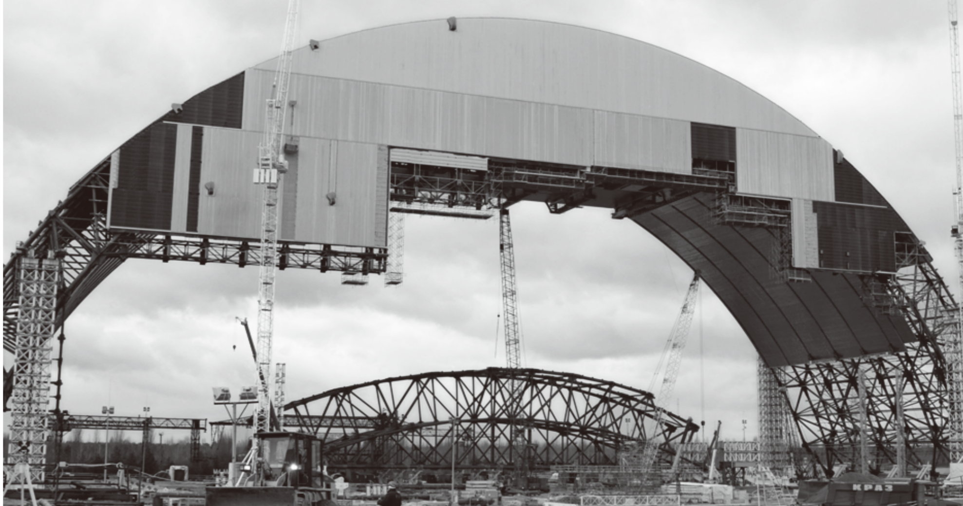
建設中のチェルノブイリ4号機・新シェルター。 4号機に隣接する場所で組み立て、完成後は レール上を移動させて石棺を覆う ©chnpp.gov.ua
