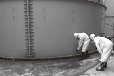
▼汚染水漏れを点検する タンクパトロール
