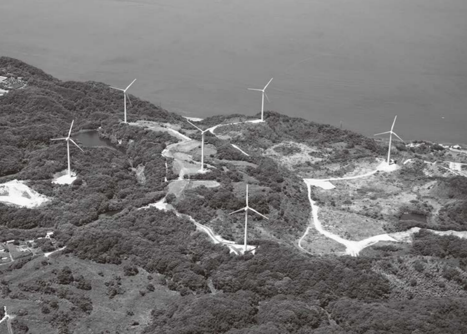
淡路風力発電所
