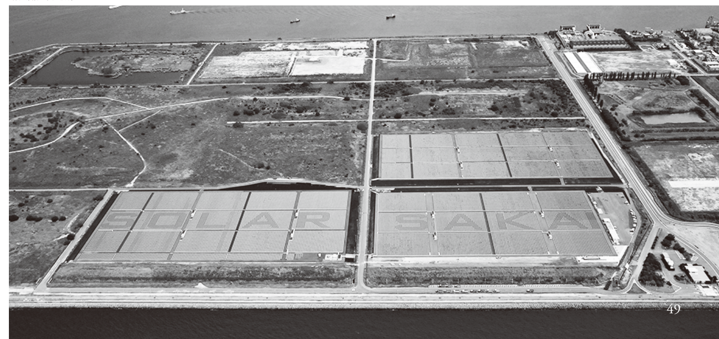
堺太陽光発電所
