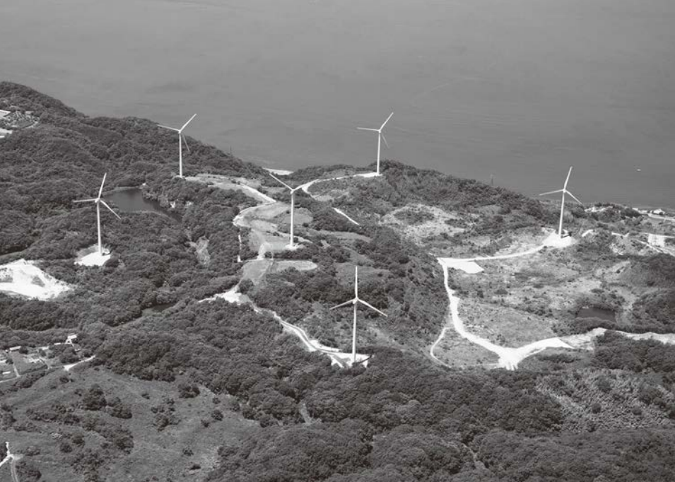
淡路風力発電所
