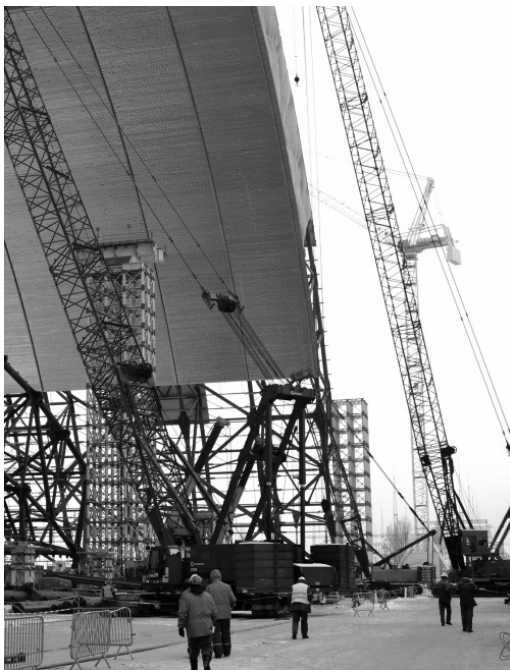
建設中のシェルターで働く人々 ©chnpp.gov.ua
