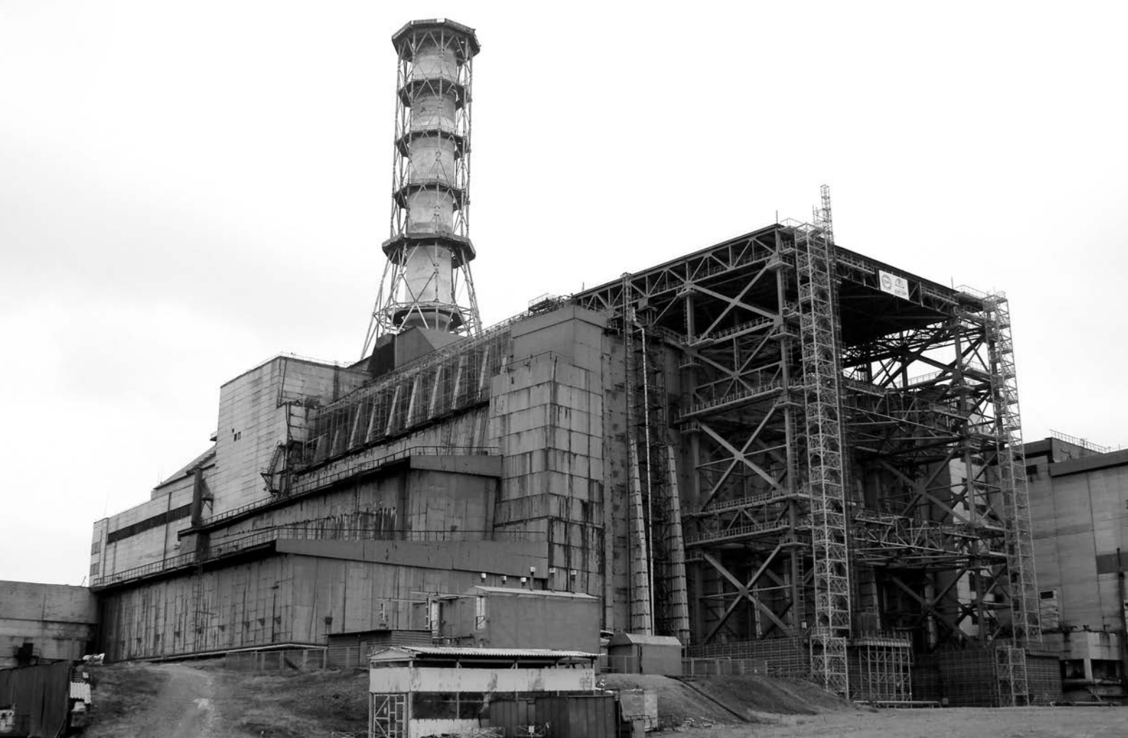
現在のチェルノブイリ4号機。08年に石棺の補強工事を完了 ©European Bank for Reconstruction and Development
