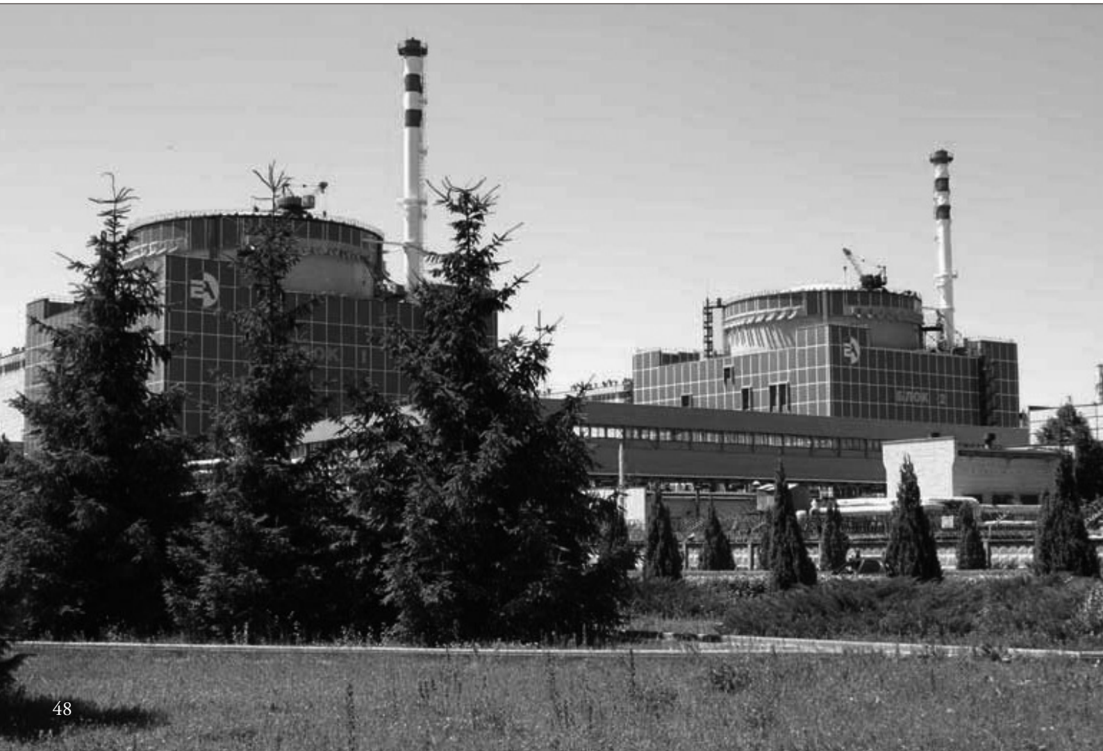
新たに2基の建設が進むフメリニツキ原子力発電所 ©Energoatom
