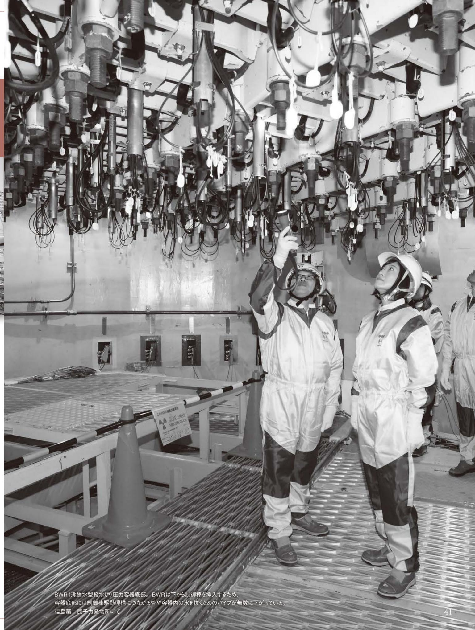
BWR(沸騰水型軽水炉)圧力容器底部。BWRは下から制御棒を挿入するため、容器底部には制御棒駆動機構につながる管や容器内の水を抜くためのパイプが無数に下がっている。福島第二原子力発電所にて
