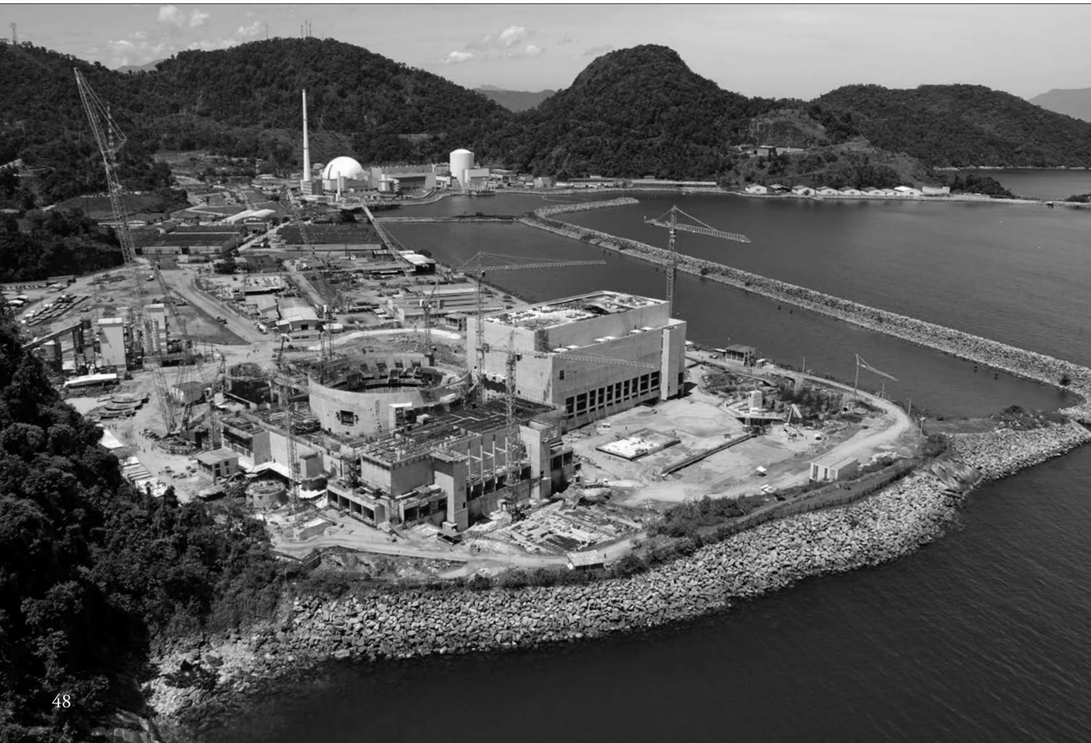
アングラ原子力発電所。手前が建設中の3号機、奥左が2号機、右が1号機 ©Acervo Eletronuclear
