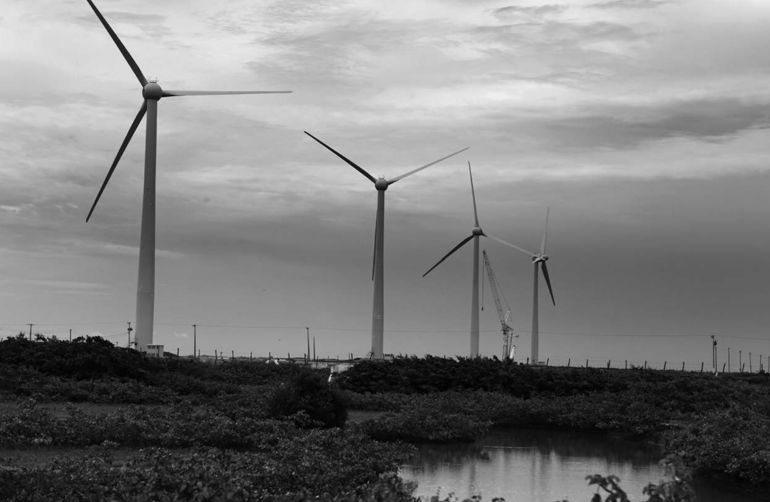
セアラ州の風力発電 ©Fotografia Eletrobrás
