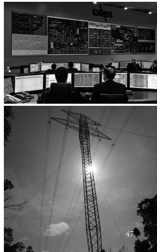
上／全国システムオペレーションセンターの管制室 ©Arquivo ONS 下／送電鉄塔 ©Fotografia Eletrobrás
