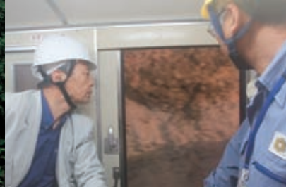
▲高熱隧道。 現在の岩盤温度は 40℃程度
