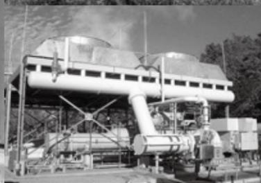
◀低沸点媒体を使うことで低温熱水での発電を可能としたバイナリー発電施設
