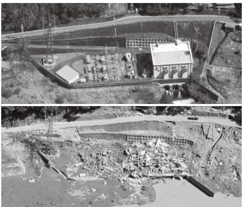
台風12号で全壊した長殿発電所(上／水害前 下／水害後)
