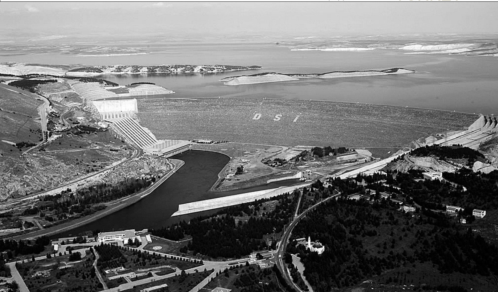
アタテュルクダム/水力発電所 ©DSI
