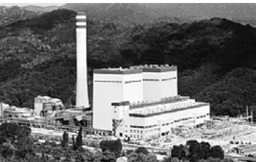
石炭火力発電所 ©Eren Enerji
