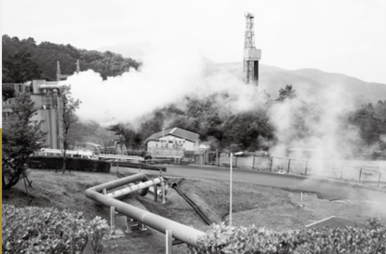
▲構内を走る二相流体輸送管。蒸気と熱水を同一配管で輸送できるため建設費も削減できるという ◀蒸気井
