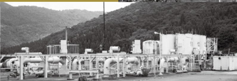
▲構内を走る二相流体輸送管。蒸気と熱水を同一配管で輸送できるため建設費も削減できるという ◀蒸気井
