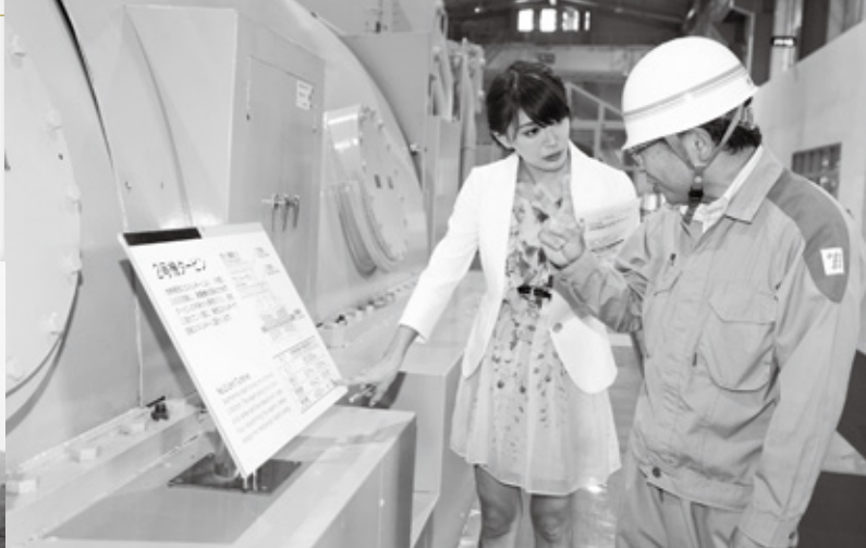
▶建屋の外に設置された変圧器 ◀タービン建屋。タービンは1分間に3600回転して発電機を回し、電気をつくる
