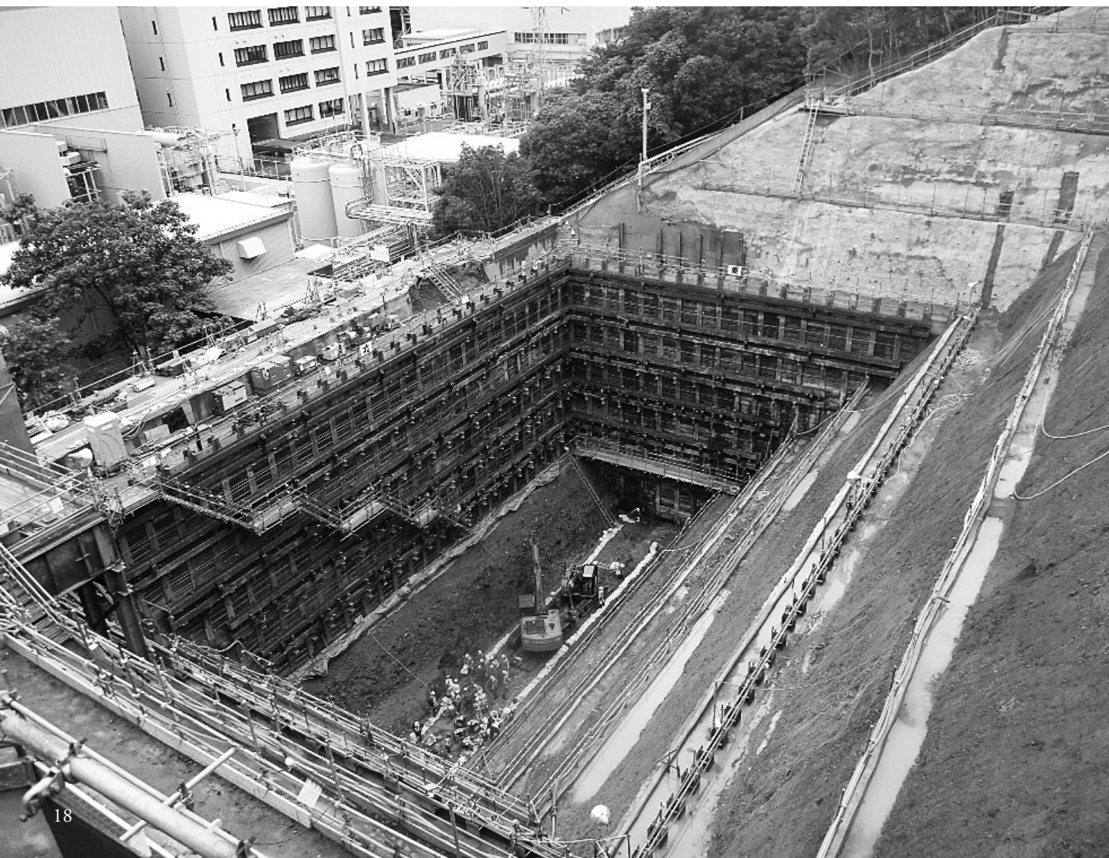
関西電力大飯発電所敷地内での破碎帯調査
