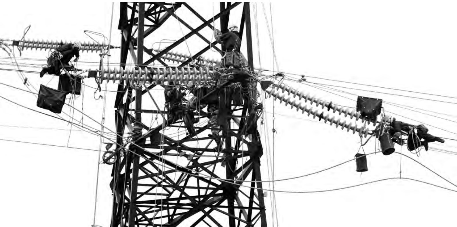
高い鉄塔に上って行う送電線の張替工事
