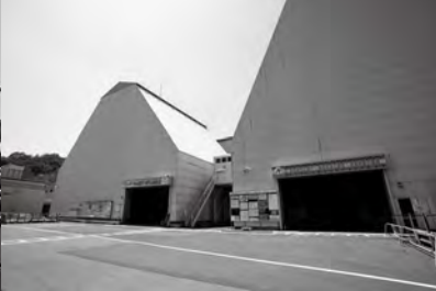
瑞浪の地上設備。防音ハウス(写真上)内には立坑掘削のための槽設備(下右)があり、隣接の建屋には掘削用巻上設備(下左)があった。構内には排水処理設備(左)も設けられている。また東濃地科学センターでは、数km～数十km四方の範囲の地下水流動を対象とした広域地下水流動研究も行っており、ボーリング調査などのデータを用いて地下水の流れを解析している。
