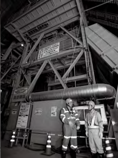
瑞浪の地上設備。防音ハウス(写真上)内には立坑掘削のための槽設備(下右)があり、隣接の建屋には掘削用巻上設備(下左)があった。構内には排水処理設備(左)も設けられている。また東濃地科学センターでは、数km～数十km四方の範囲の地下水流動を対象とした広域地下水流動研究も行っており、ボーリング調査などのデータを用いて地下水の流れを解析している。
