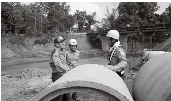
上／ラオス ナムニアップ水力 ダムサイトへの道路改良工事の状況 中／移転村の子供たち 下／パイロットプラントの水田
