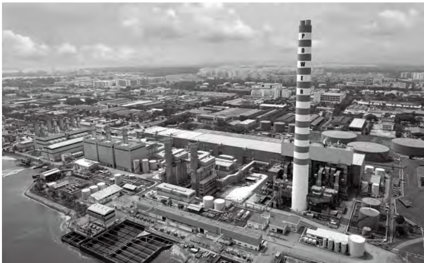
シンガポール セノコ火力発電所
