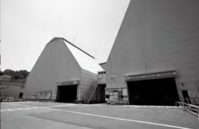
瑞浪の地上設備。防音ハウス(写真上)内には立坑掘削のための槽設備(下右)があり、隣接の建屋には掘削用巻上設備(下左)があった。構内には排水処理設備(左)も設けられている。また東濃地科学センターでは、数km～数十km四方の範囲の地下水流動を対象とした広域地下水流動研究もっており、ボーリング調査などのデータを用いて地下水の流れを解析している。
