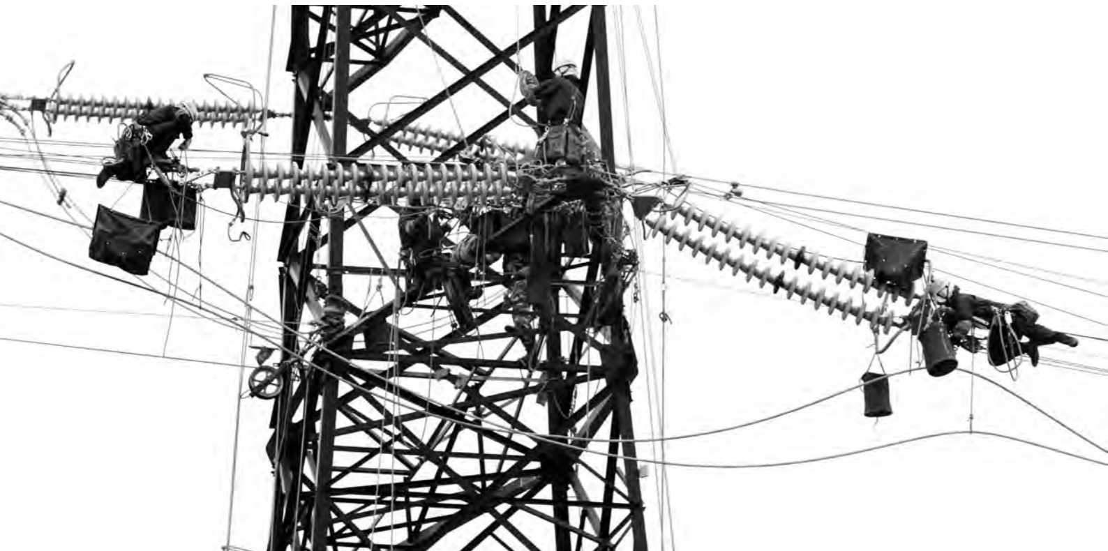
高い鉄塔に上って行く送電線の張替工事
