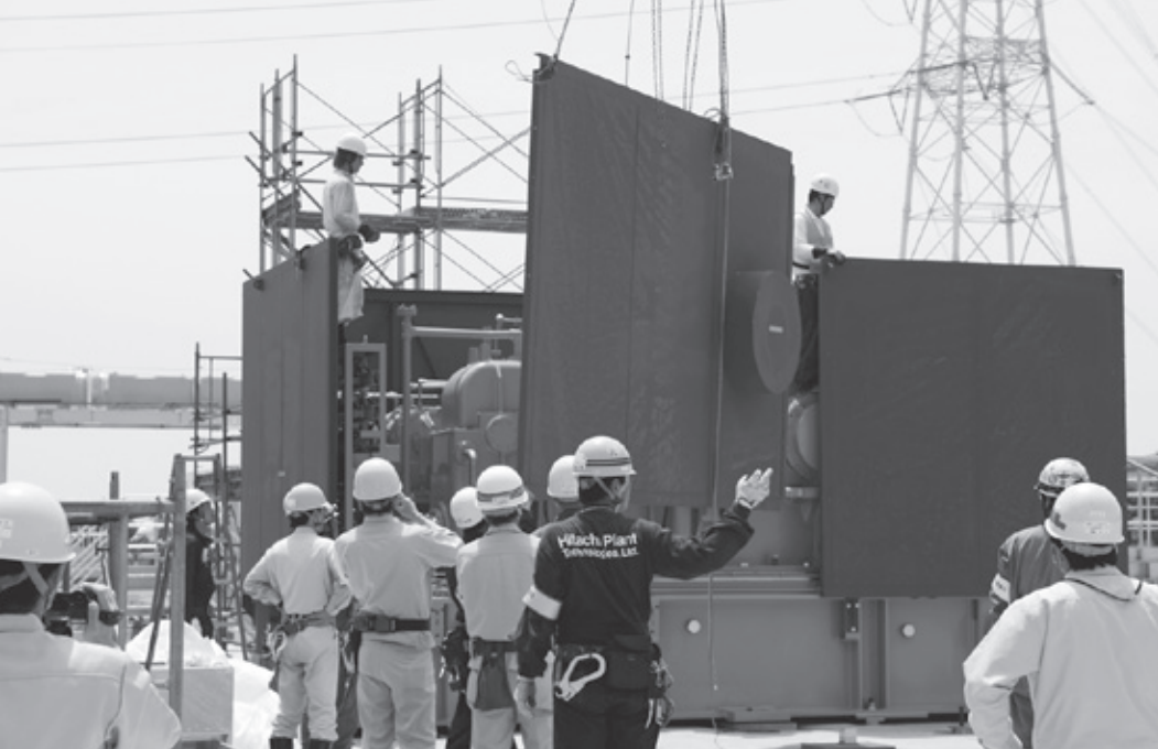
緊急対策として姫路第一発電所に小型ガスタービンを設置
