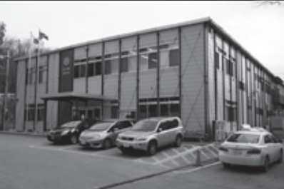
▲女川町役場も被災し、現在は仮設庁舎で業務を行っている
