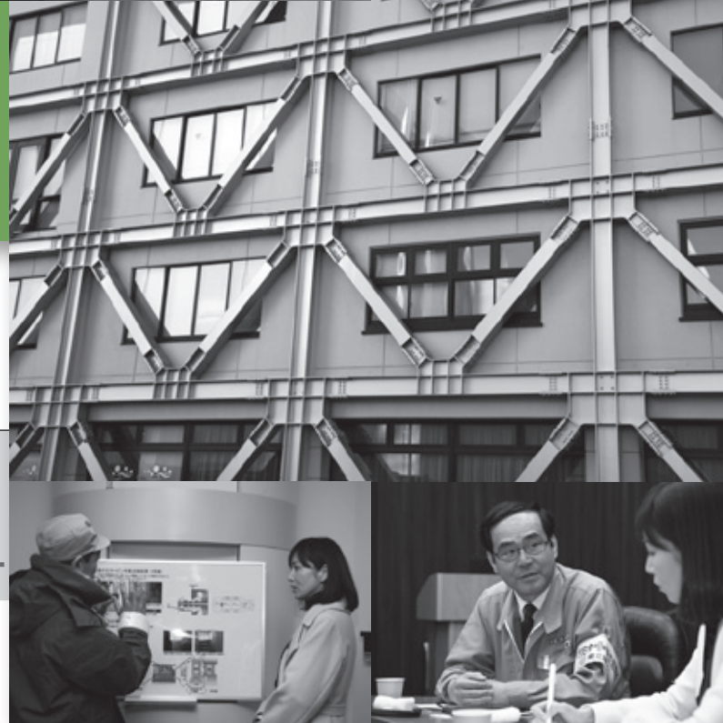
▼事務棟(旧館)は、07年の 中越沖地震を教訓に10 年3月には耐震補強工事 (筋交い)を完了していた
