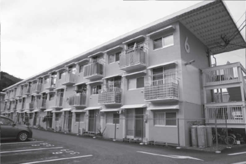
▲2011年11月に完成した日本初の3階建て仮設住宅は、海上輸送用コンテナを組み合わせたもの。適切な用地がなく、町営球場の中に建設したそうで、スタンドはそのまま
