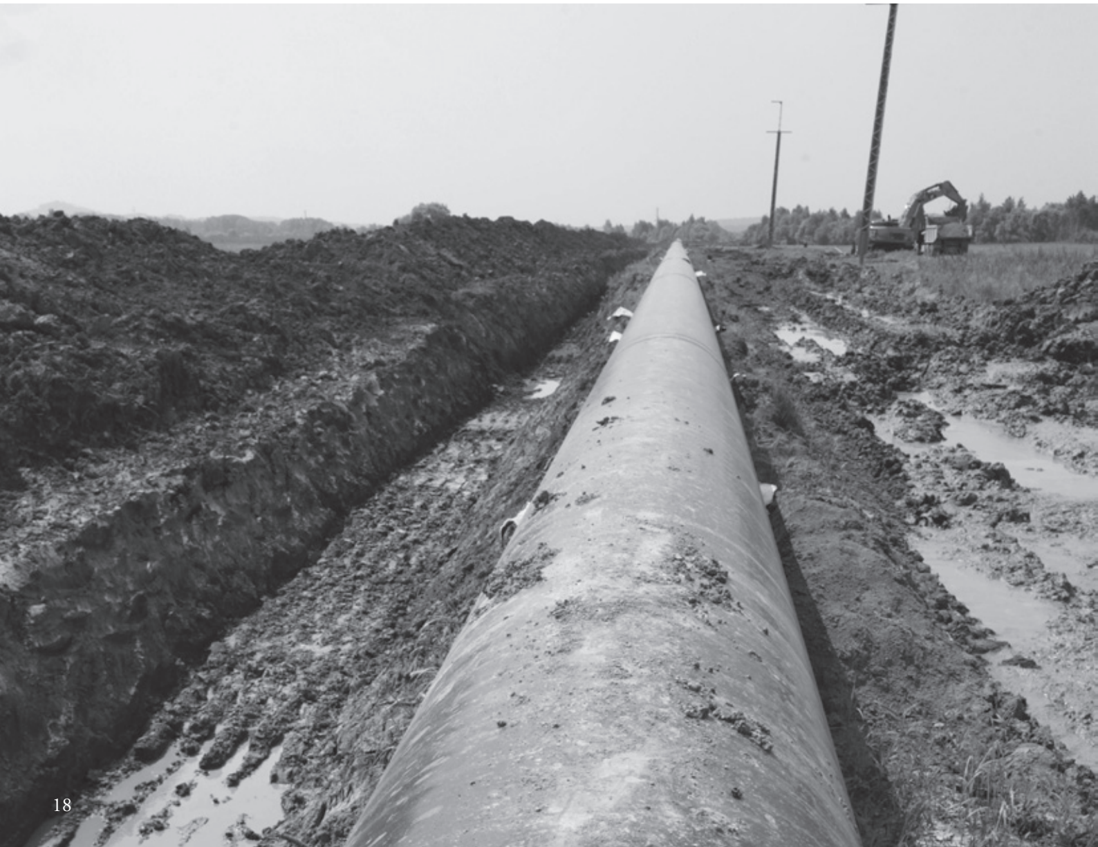
ロシア・サハリンで建設中のアジア向けガスパイプライン ©PPS通信社
