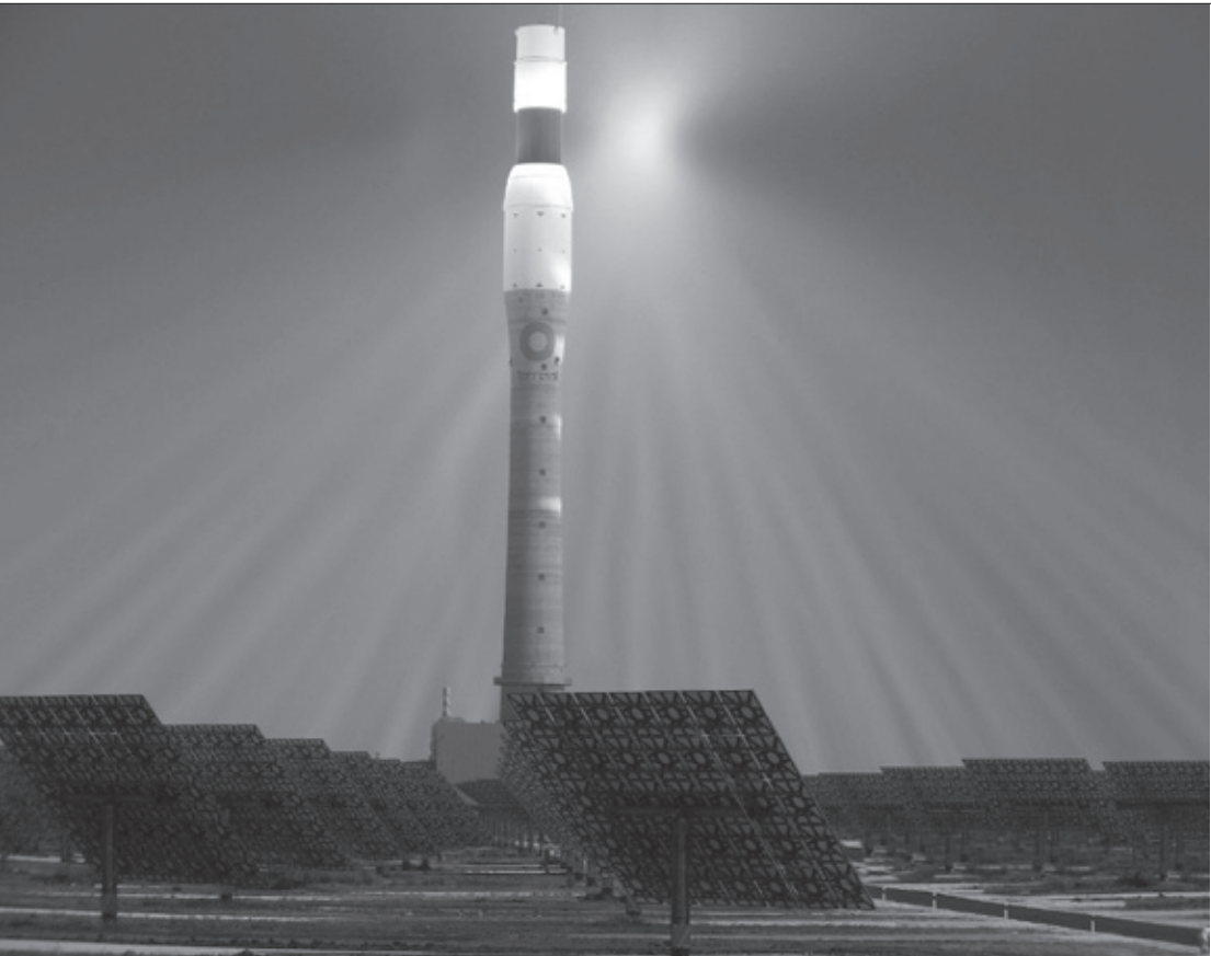
夜も稼動する「ヘマソラール集光型太陽熱発電所」。約2600枚の反射鏡が太陽光をタワー上部に集め、熔融塩タンクに蓄熱。この熱で蒸気をつくりタービンを回して発電するといしくみ。トレソル・エナジー社により2011年運転開始
