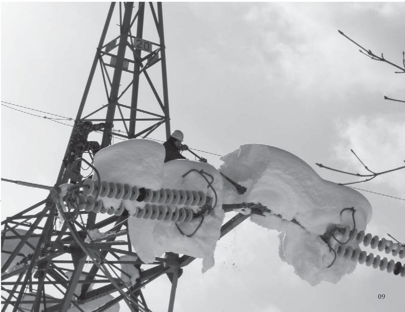
社会・生活のライフラインである電気を守る。送電鉄塔の雪降ろし
