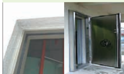
扉のシール施工
