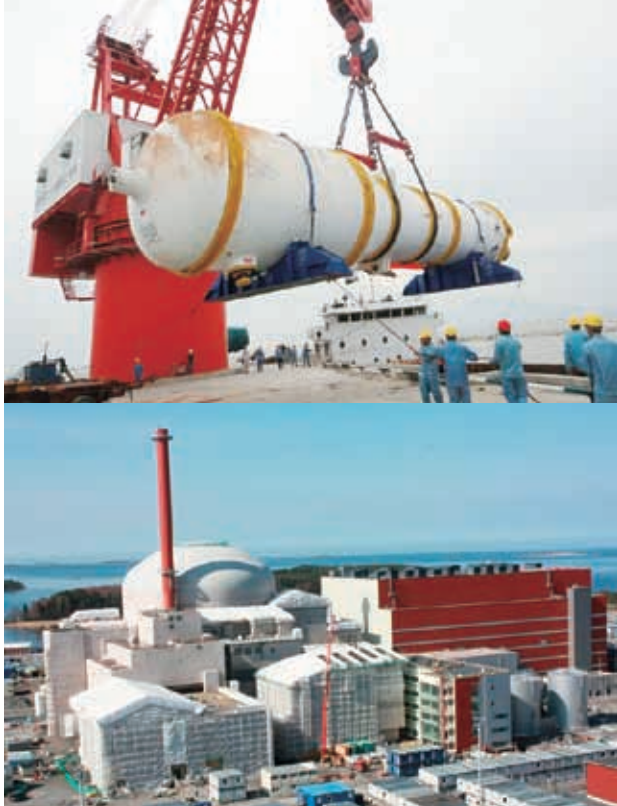
上／中国・台山に到着したEPRの蒸気発生器 ©AREVA 下／フィンランド・オルキオで建設中のEPR ©AREVA
