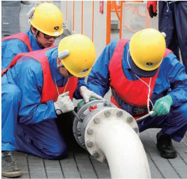
冷却用の海水取り込み口にホースをつなぐ訓練
