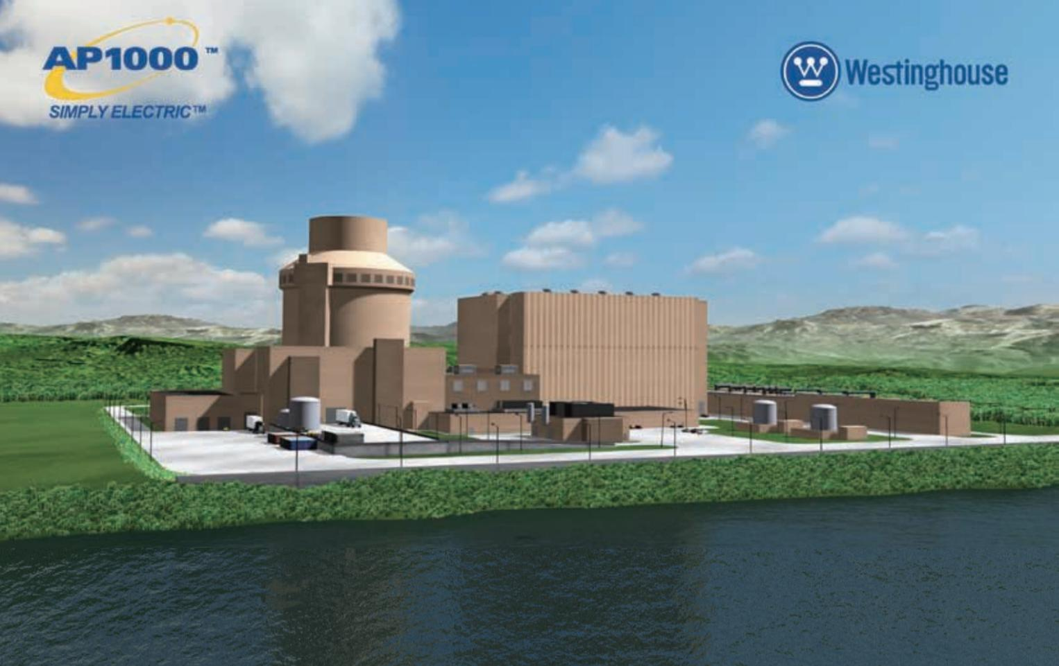
側の壁が衝突に対する予防壁の役割を果たしています。二重構造で守られているのは炉心だけでなく、緊急用ディーゼル発電や燃料プールなど、主要設備のほとんどが厳重に保護されています」
