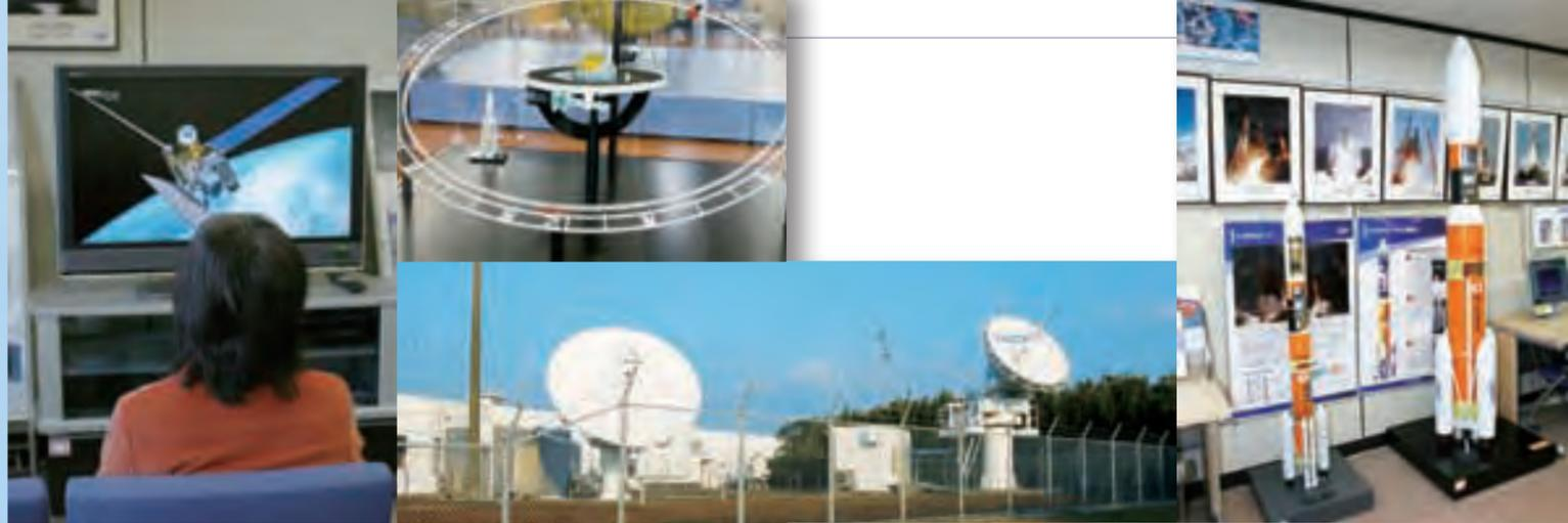
種子島空港近くの地に、74年に設置された増田宇宙通信所。構内には、「だいち」や「いぶき」などの人工衛星追跡用とロケット追尾用の「パラボラアンテナ」が7基、点在している。各パラボラアンテナは衛星やロケットの状態・位置・姿勢などのデータを受信するほか、衛星の動きに修正が必要なときは指令信号を送り制御(管制)している。「だいち」は1月19日に新燃岳の噴火を観測し、その後も観測を続けているという。
