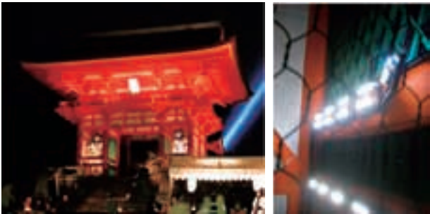
清水寺仁王像ライトアップ(左)と仁王門内に設置されたLED投光器
