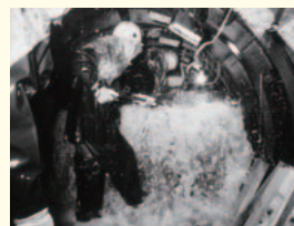
長野県大町側からのトンネル工事は破砕帯に阻まれた
