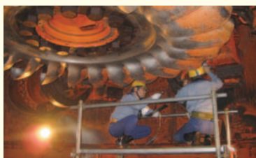
点検作業は可能なかぎり若手従業員と組んでおこない技術や技能を伝承
