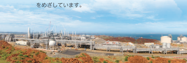
ブルートLNGプロジェクト陸上基地外観 (西オーストラリア州)
