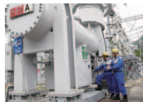
変電所での作業のようす
