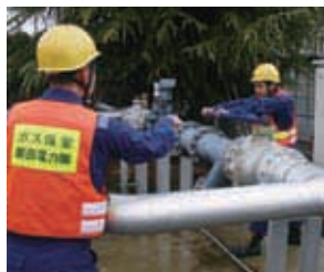
緊急時のガス供給弁閉止の訓練
