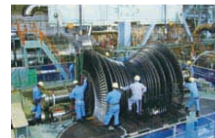
タービンを分解しての定期点検工事
