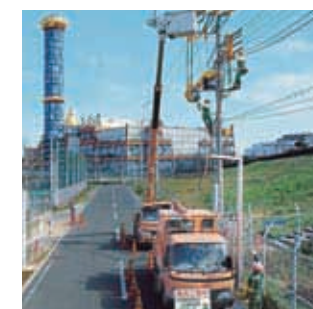
配電線工事のようす
