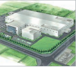
リチウムイオン二次電池の製造を担う ㈱リチウムエナジー ジャパンの新工場 完成予想図（滋賀県栗東市）
