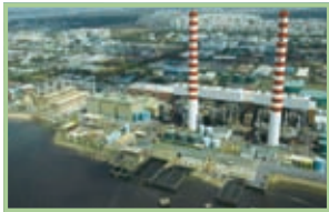
セノコ発電所
