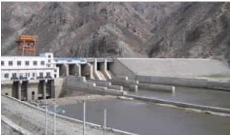
ルエタイ水力発電所
