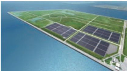
堺第7-3区太陽光発電所（仮称）
