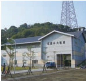
名間水力発電所
