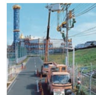
配電線工事のようす
