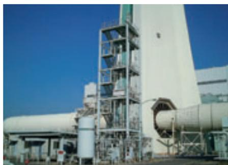
排煙脱炭のための試験プラント (南港発電所)
