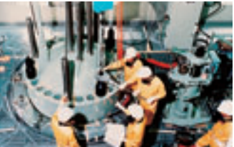
実機と同等の原子炉容器を使い、上蓋のボルト締付け作業を訓練
