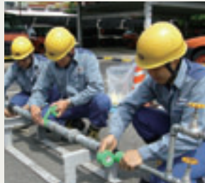
ガス漏洩修理訓練
